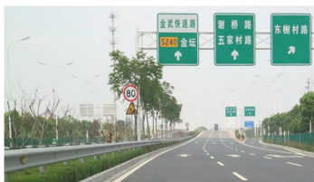
快速路 金武快速路
